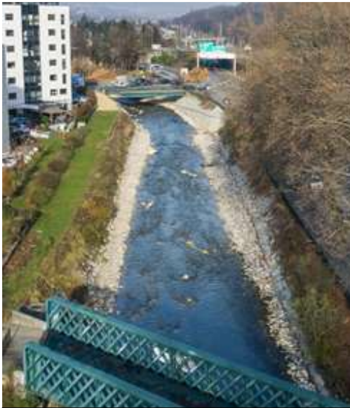
Augmentation de la section de la rivière dans un secteur où la Leysse a débordé en février 1990. 2015.
