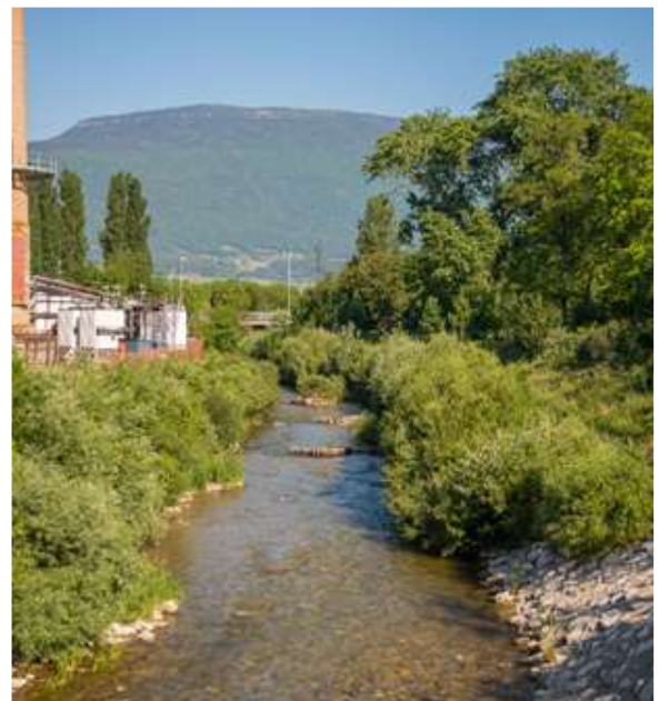
Végétalisation des berges et des fascines, favorisant la diversification du fond du lit.
