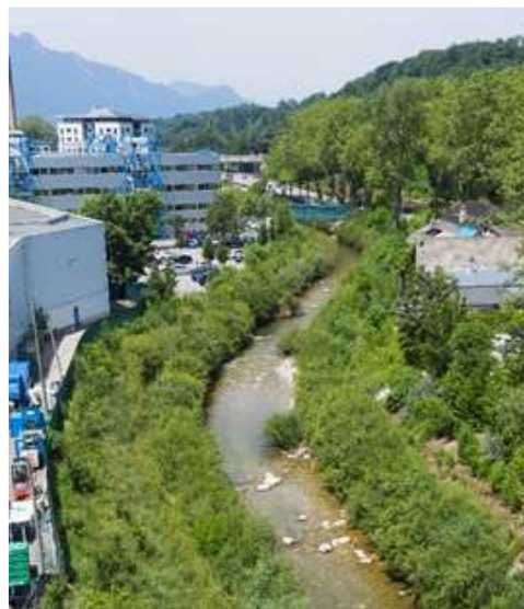
Végétalisation des berges et diversification du fond du lit (banquettes, épis...). 2019.
