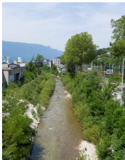
Végétalisation des berges et diversification du fond du lit (banquettes, épis...). 2019.
