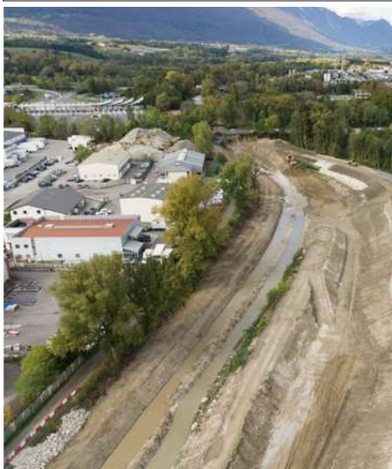
Plus en aval, travaux d'élargissement et de confortement de la digue rive droite. Dévoiement des réseaux pour les sortir de la digue. Création de la nouvelle piste cyclable, plus proche du cours d'eau. 2017.
