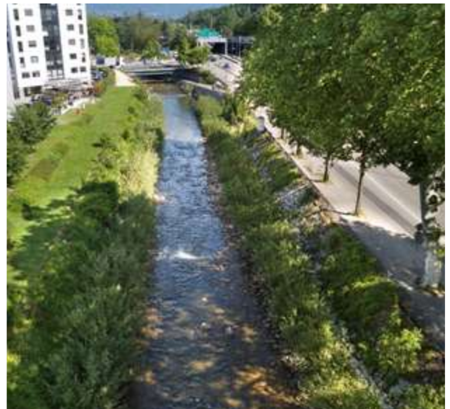
Végétalisation des berges et diversification du fond du lit (banquettes, épis...).
