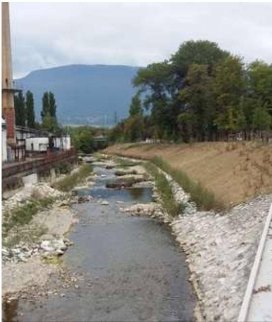
Amélioration des écoulements par suppression d'un seuil et élargissement de la section de la Leysse. 2015.
